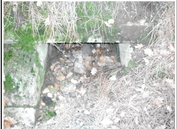
FOTO Nº 20: Tajera de piedra existente de sección 80 x 90 cm → Obra de Drenaje Transversal ODT-2 en PK 30+731,70 MD
