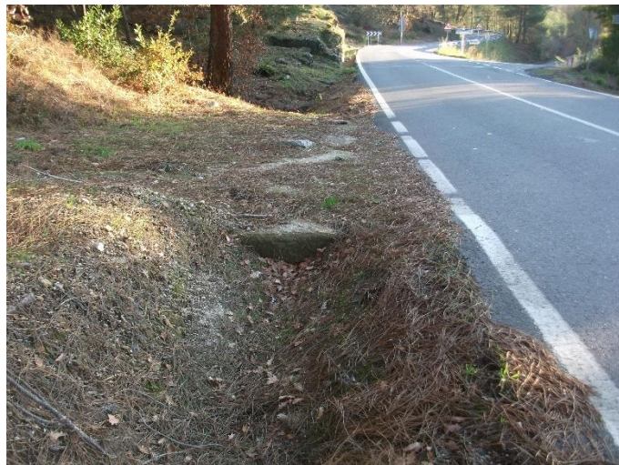
FOTO Nº 17: Vista del Drenaje Longitudinal actual – paso salvacunetas pista PK 30+730 MI
