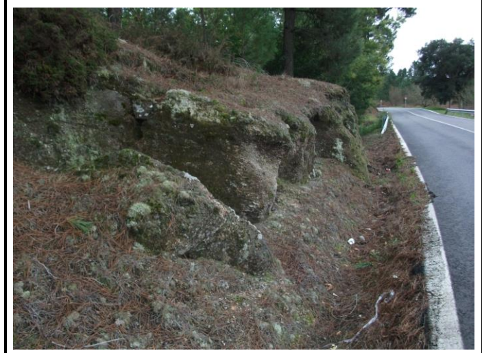
FOTO Nº 40: Vista del tipo de terreno existente → talud de desmante en piedra sana PK 31+270
