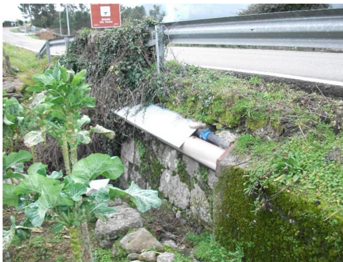
FOTO Nº 67: Pontón de piedra en PK 31+760 MI - estrecho 6m con servicios grapados a laterales (abast. y saneamiento)
