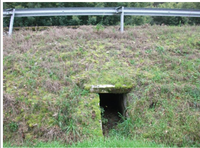
FOTO Nº 42: Tajeta de piedra existente de sección 80 x 90 cm → Obra de Drenaje Transversal ODT-7 en PK 31+296,50 MD
