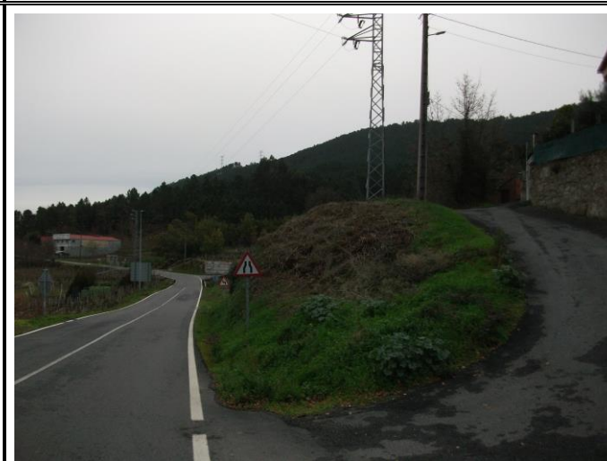
FOTO Nº 72: Zona estrecha PK 31+850 condicionada por torre eléctrica-alta en MI y acceso a viñedos bajos-muro en MD
