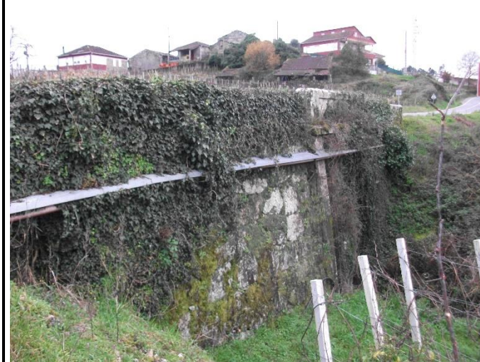
FOTO Nº 68: Pontón de piedra en PK 31+760 MD - estrecho 6m con servicios grapados a laterales (abast. y saneamiento)
