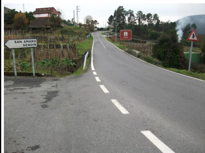
FOTO Nº 65: Intersección en PK 31+740 con viñedos y junto a pontón de piedra en regato–zona estrecha-servicios enterados
