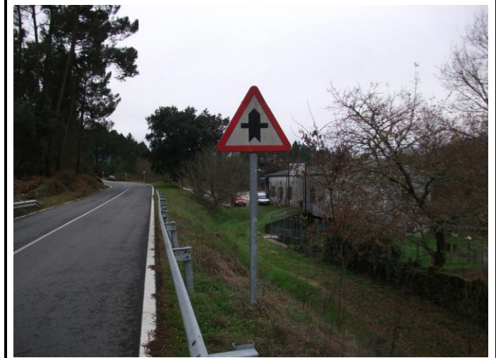
FOTO Nº 44: Trazado actual de la OU-402 a media ladera en PK 31+300 MD con pista paralela más baja - acceso a viñedos
