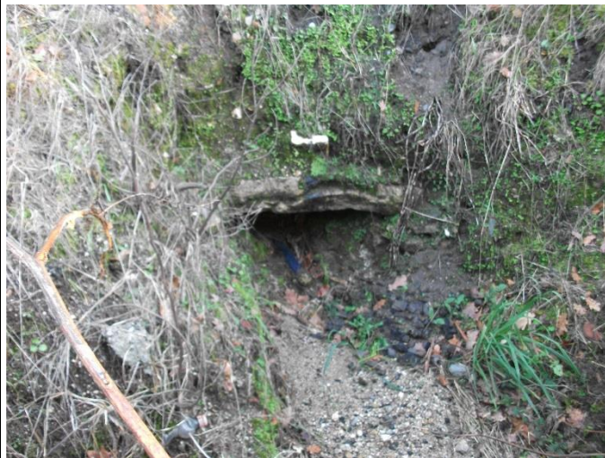
FOTO Nº 19: Tajera de piedra existente de sección 80 x 90 cm → Obra de Drenaje Transversal ODT-2 en PK 30+731,70 MI
