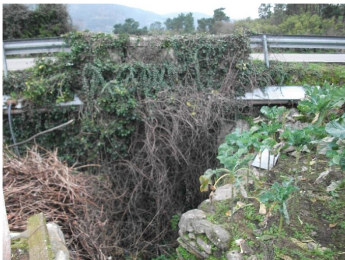
FOTO Nº 66: Pontón de piedra en PK 31+760 MI - estrecho 6m con servicios grapados a laterales (abast. y saneamiento)
