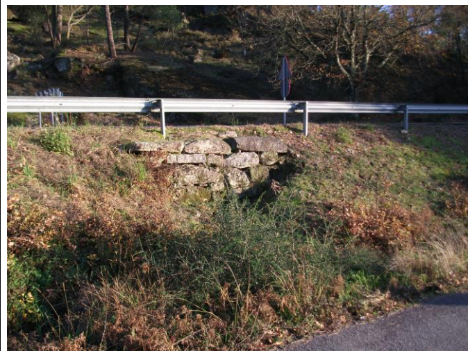
FOTO Nº 23: Vista del muro de mampostería que sostiene la OU-402 en el PK 30+790 hacia la carretera de acceso a Reza
