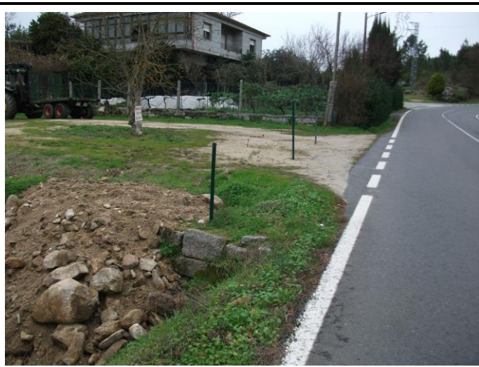
FOTO Nº 62: Tramo urbanizado-alcantarillado, abastecimiento, alumbrado y electricidad- MD –PK 31+580 al final
