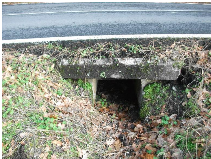
FOTO Nº 37: Tajeta de piedra existente de sección 50 x 50 cm → Obra de Drenaje Transversal ODT-5 en PK 31+188,10 MD
