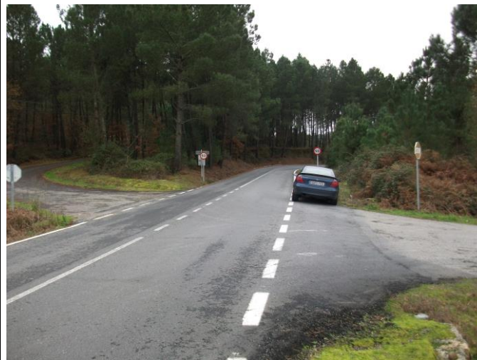
FOTO Nº 47: Intersección con pistas asfaltadas en PK 31+430
