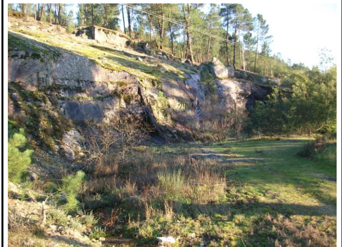
FOTO Nº 24: Vista de la Cantera abandonada en el borde de la OU-402 en el PK 30+900 MI
