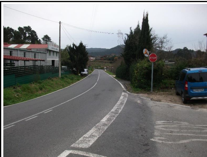
FOTO Nº 61: Tramo urbanizado-alcantarillado, abastecimiento, alumbrado y electricidad- desde PK 31+580 al final
