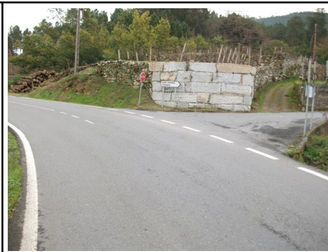
FOTO Nº 64: Intersección en PK 31+740 con viñedos y junto a pontón de piedra en regato–zona estrecha-servicios enterados
