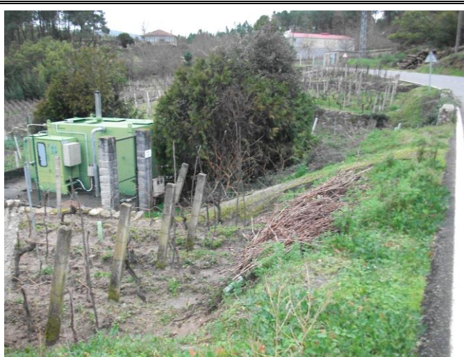
FOTO Nº 71: Depuradora de aguas residuales EDAR existente en MI de la OU-402 en PK 31+770
