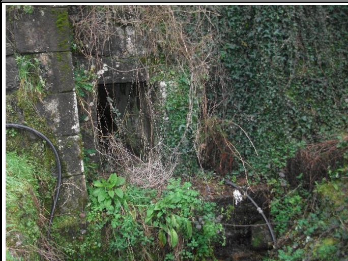
FOTO Nº 69: Pontón de piedra en PK 31+760 MD - estrecho 6m con servicios grapados a laterales (abast. y saneamiento)
