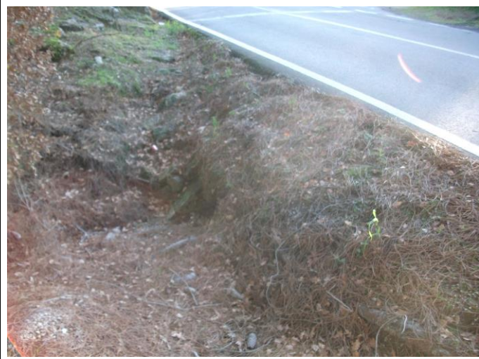
FOTO Nº 18: Tajera de piedra existente de sección 80 x 90 cm → Obra de Drenaje Transversal ODT-2 en PK 30+731,70 MI
