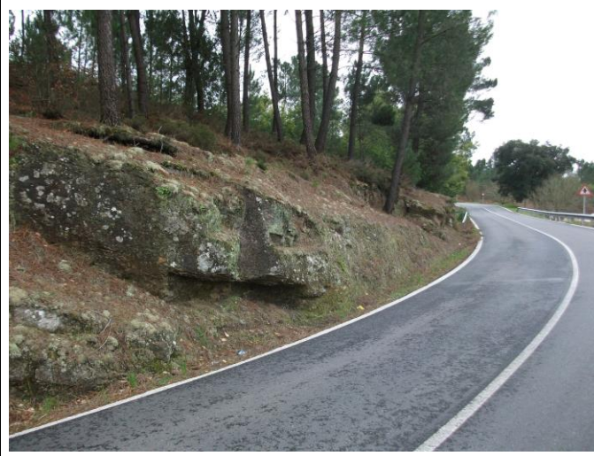
FOTO Nº 39: Vista del tipo de terreno existente → talud de desmante en piedra sana PK 31+270
