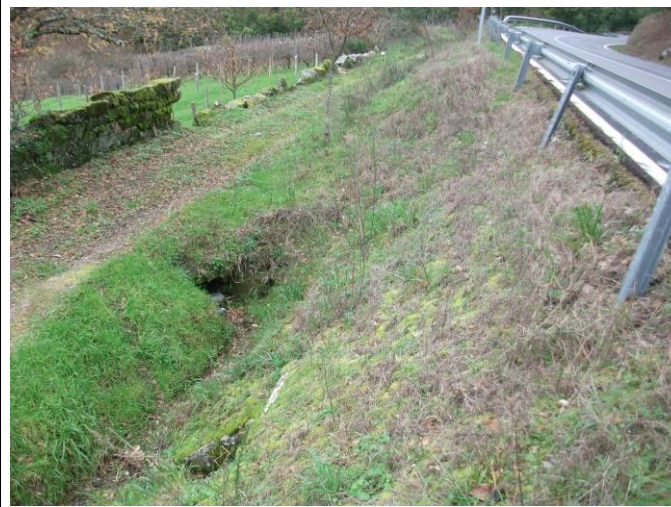
FOTO Nº 43: Tajeta de piedra existente de sección 80 x 90 cm → Obra de Drenaje Transversal ODT-7 en PK 31+296,50 MD
