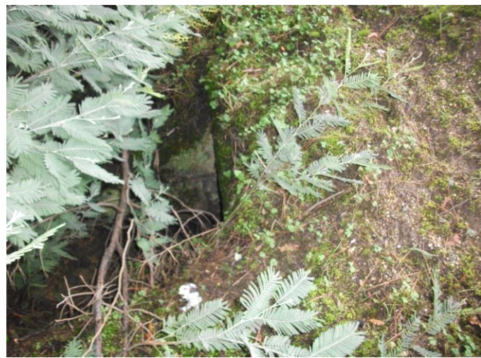
FOTO Nº 41: Tajeta de piedra existente de sección 80 x 90 cm → Obra de Drenaje Transversal ODT-7 en PK 31+296,50 MI
