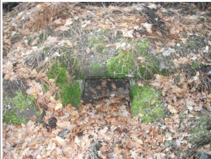
FOTO Nº 38: Tajeta de piedra existente de sección 50 x 50 cm → Obra de Drenaje Transversal ODT-6 en PK 31+224,45 MI
