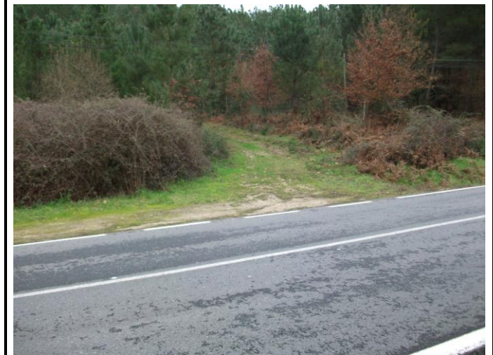
FOTO Nº 48: Intersección con pista en PK 31+430 – pista de tierras acceso a fincas en MI
